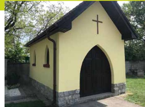
In Leopoldsdorf wurde das Dach des Kapellenschiffs mit dem Hochdruckreiniger vom Moos befreit und anschließend mit einem geeigneten Lack versiegelt. Das Blechdach am Turm wurde entrostet und danach ebenfalls lackiert, außerdem wurden die defekten Fenster renoviert.
