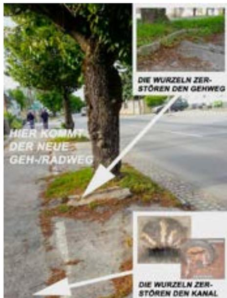
heuer abgeschlossen. Die Wurzeln der wunderschönen Zierkirschen haben über die Jahre die Asphaltsschicht der bestehenden Gehwege stark in Mitleidenschaft gezogen. Da die Zierkirschen Flachwurzler sind und das Wurzelwerk eine Gefahr für Kanal-, Gas- und Stromleitungen sowie für die neue Gehwege darstellt, müssen diese schweren Herzens zugunsten von Neupflanzungen weichen.
