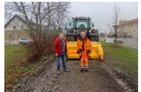
Fräsarbeiten entlang der ehemaligen Bahntrasse für den neuen Radweg
