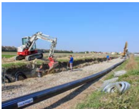
Verlegearbeiten der überregionalen Trinkwasserleitung zwischen Leopoldsdorf und Breitstetten
