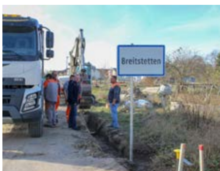
Straßenerrichtung an der Schwemme in Breitstetten
